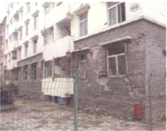
图6 北东幢严重破坏(南立面)
