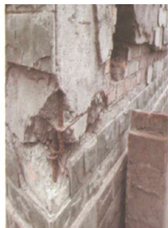
图 17 构造柱预埋钢筋搭接长度不足
