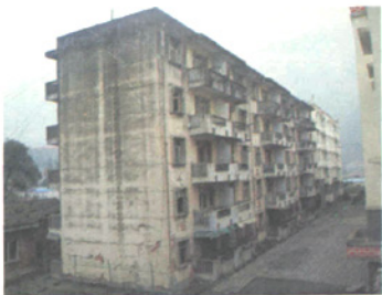
图 8 北西幢严重破坏(南立面)
