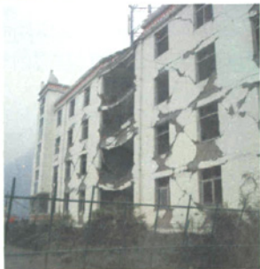
图 10 ~ 图 13 学生宿舍楼残存 4 层(南立面,山墙,北立面和局部)
