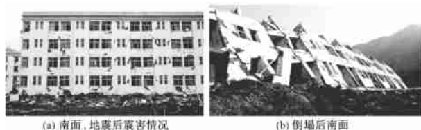
图11 教工宿舍 I 震害照片
