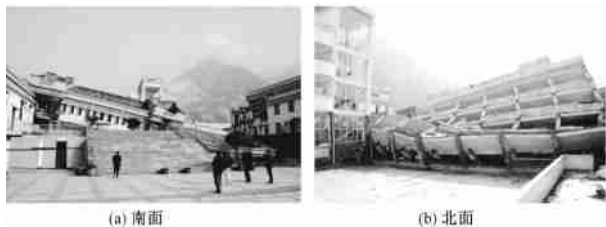
图2 教学楼 A 的震害照片
